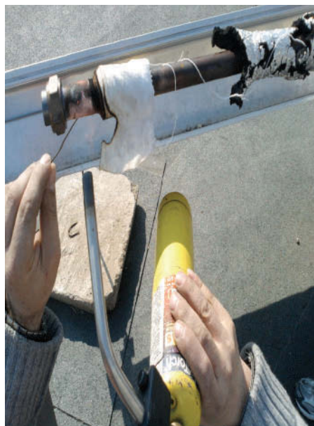
Fig.3 Brazarea cu cupru fosfor efectuată la instalația solară
