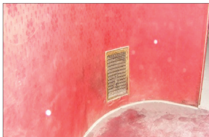
Fig.5 Grile de introducere montate în pereții despărțitori ai lojelor – înainte de restaurare
