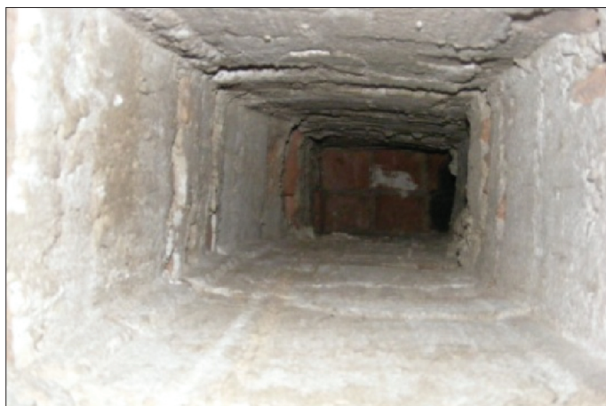
Fig.4 Canale verticale practicate în zidărie – înainte de restaurare
