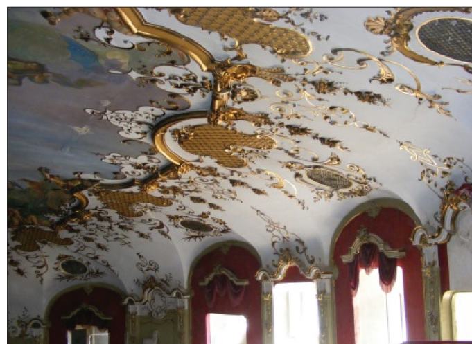
Fig.7 Grile de aspirație în plafonul sălii
