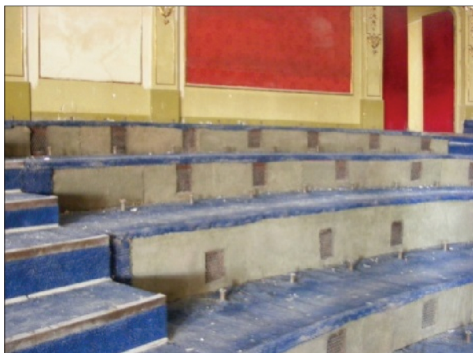
Fig.3 Grile de introducere amplasate pe camera de distribuție a aerului sub gradenele balconului - înainte de restaurare
