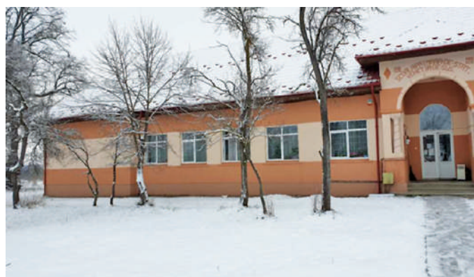
Fig. 7. Reference building - Veneția de Sus
