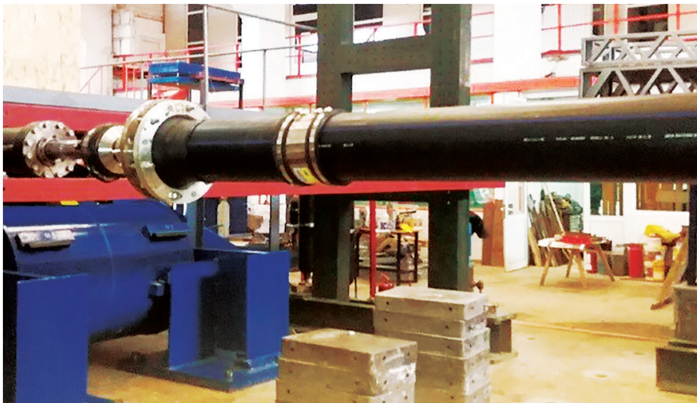
Fig.1. Îmbinarea tronsoanelor de conductă cu armătură Flexseal SC250
