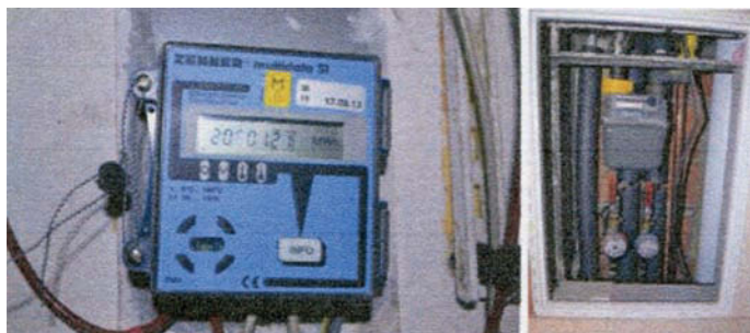
Fig. 7. Măsurarea consumului de energie
