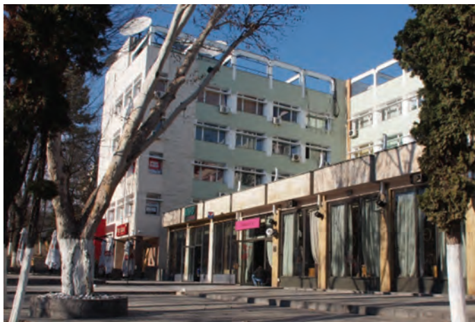
Clădirea HABITAT Iași
