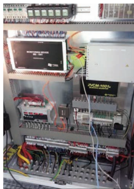
Fig.3 Vedere a cofretului de monitorizare on-line a transformatoarelor-versiunea 2016
