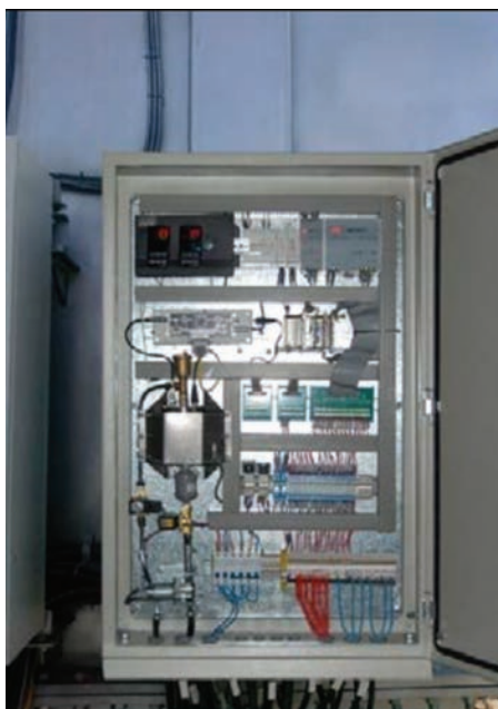
Fig. 2 Vedere a cofretului de monitorizare on-line a transformatoarelor-versiunea 2010
