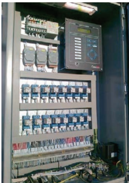
Fig.1 Vedere a cofretului de monitorizare on-line a transformatoarelor-versiunea 2008
