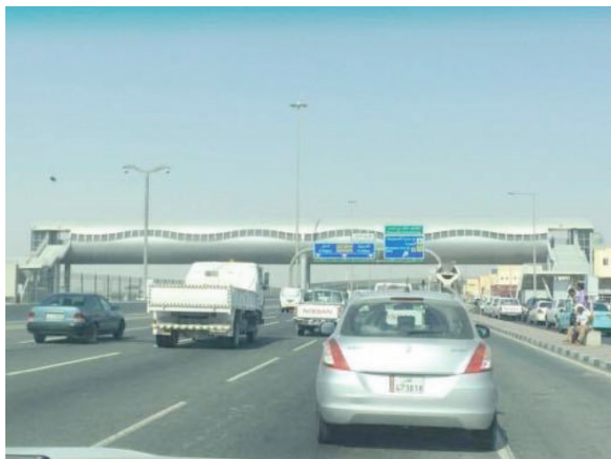
Vedere generală pasarelă (foto ing. Mateescu Monica)
