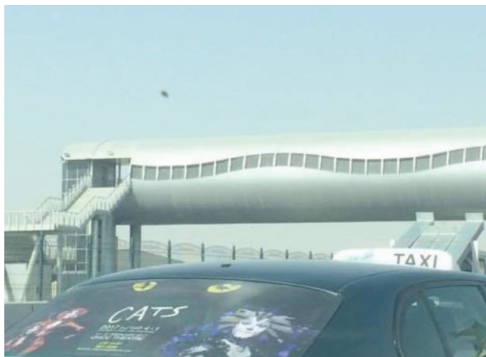
Vedere pasarelă spre dreapta (se văd unitățile exterioare de climatizare) (foto ing. Monica Mateescu)
