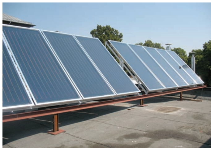
Foto 3. Dispunerea captatorilor solari plani pe acoperiș
