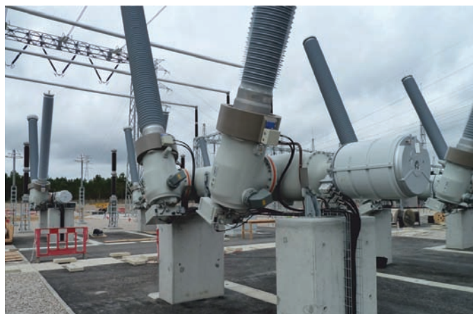
Monitorizarea PD pe un GIS hibrid
