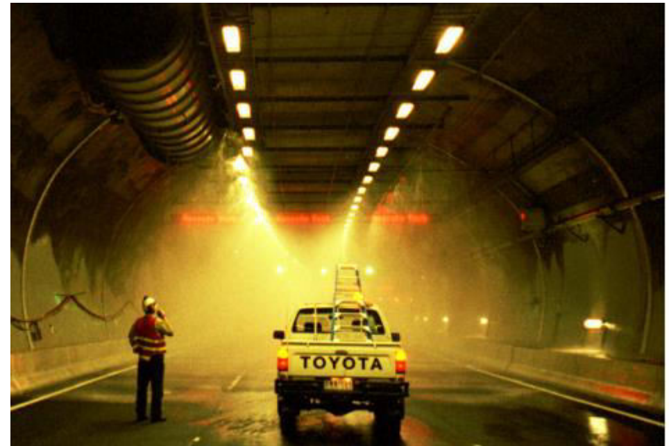
Test de stingere a unui incendiu, înainte de deschiderea tunelului, 2000
