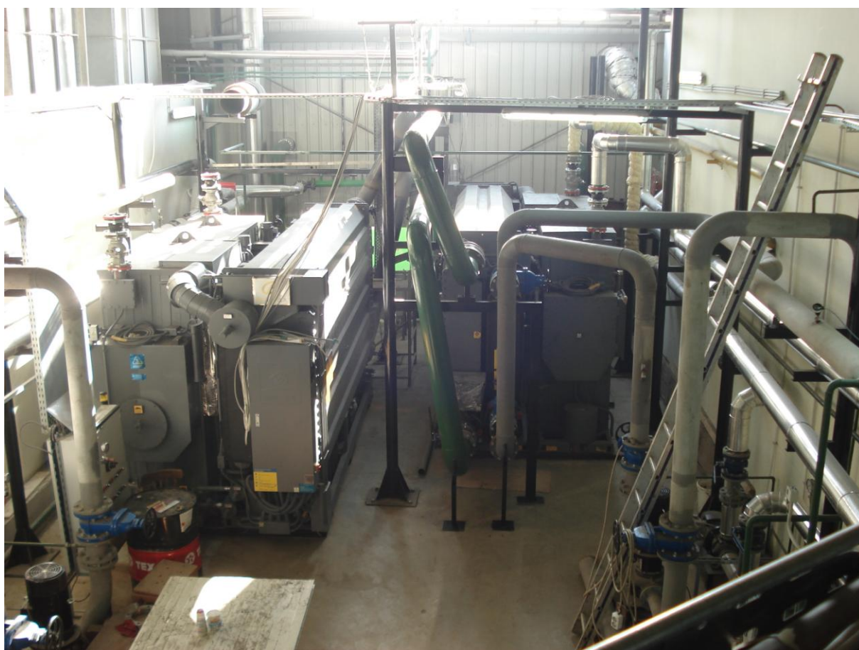
Figura 5.1: Sistemele cu absorbție cu dublu efect din instalația de la Spicu (Chitila)
