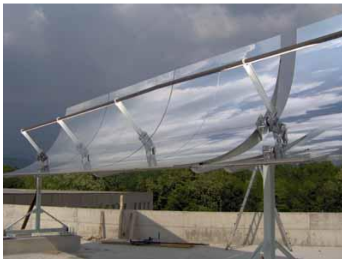
Figura 7.3: Captator solar cilindrico-parabolic
