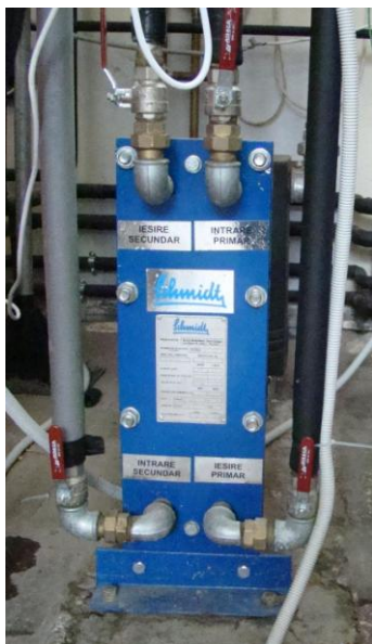
Figura 5.7: Schimbător de căldură cu plăci
