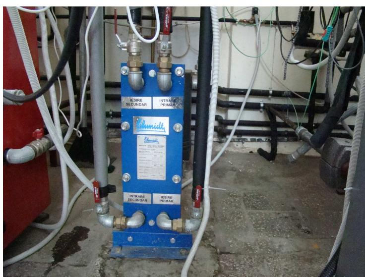
Fig. 4.11. Vedere ansamblu amplasare schimbator de caldura cu placi in instalatie.
