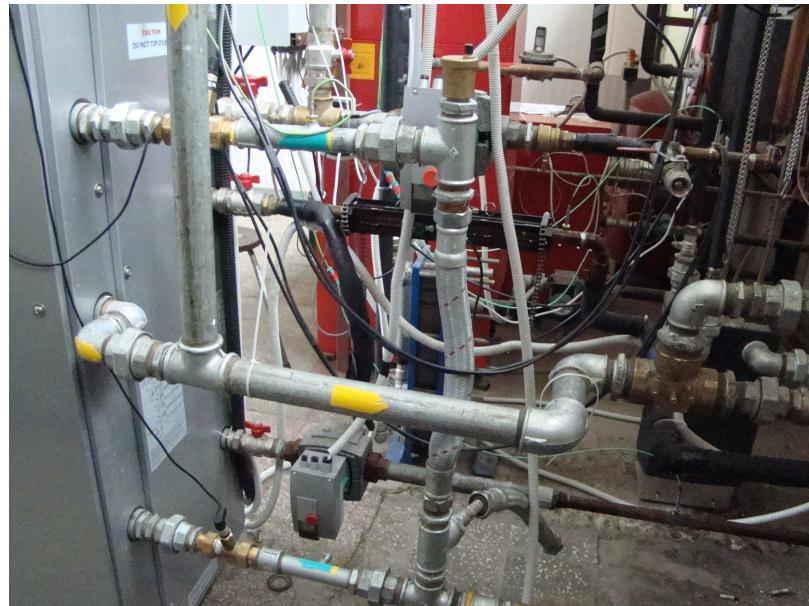
Fig. 4.20. Vedere de ansamblu amplasare senzori de debit si temperatura circuit apa de racire la absorbitor si condensator.
