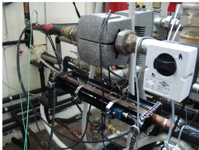
Fig. 4.13. Vedere de ansamblu ventil cu 3 cai amplasat aspiratia in fierbator.
